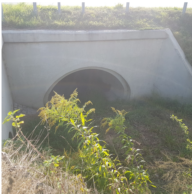
Przepust w osi rowu CL-2 – pod drogą wojewódzką.
