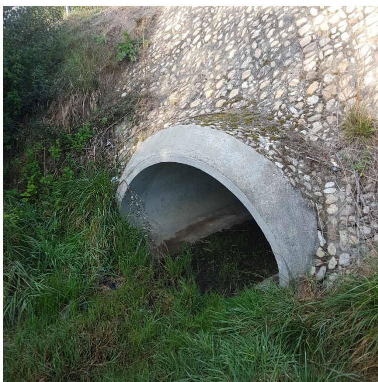
Przepust w osi rowu CL-2-30 – pod drogą wojewódzką.
