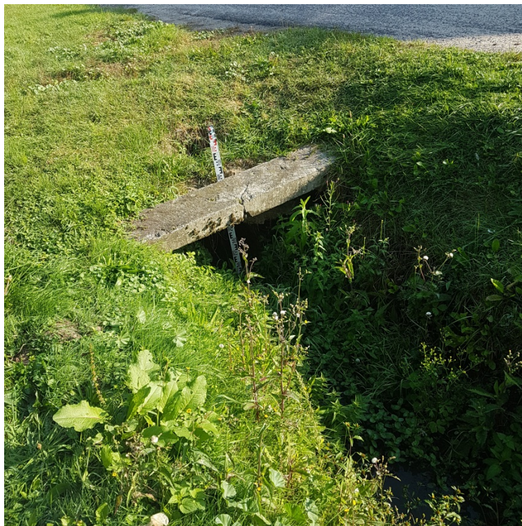
Rurociąg w osi rowu CL-2-30 do przebudowy (wlot).
